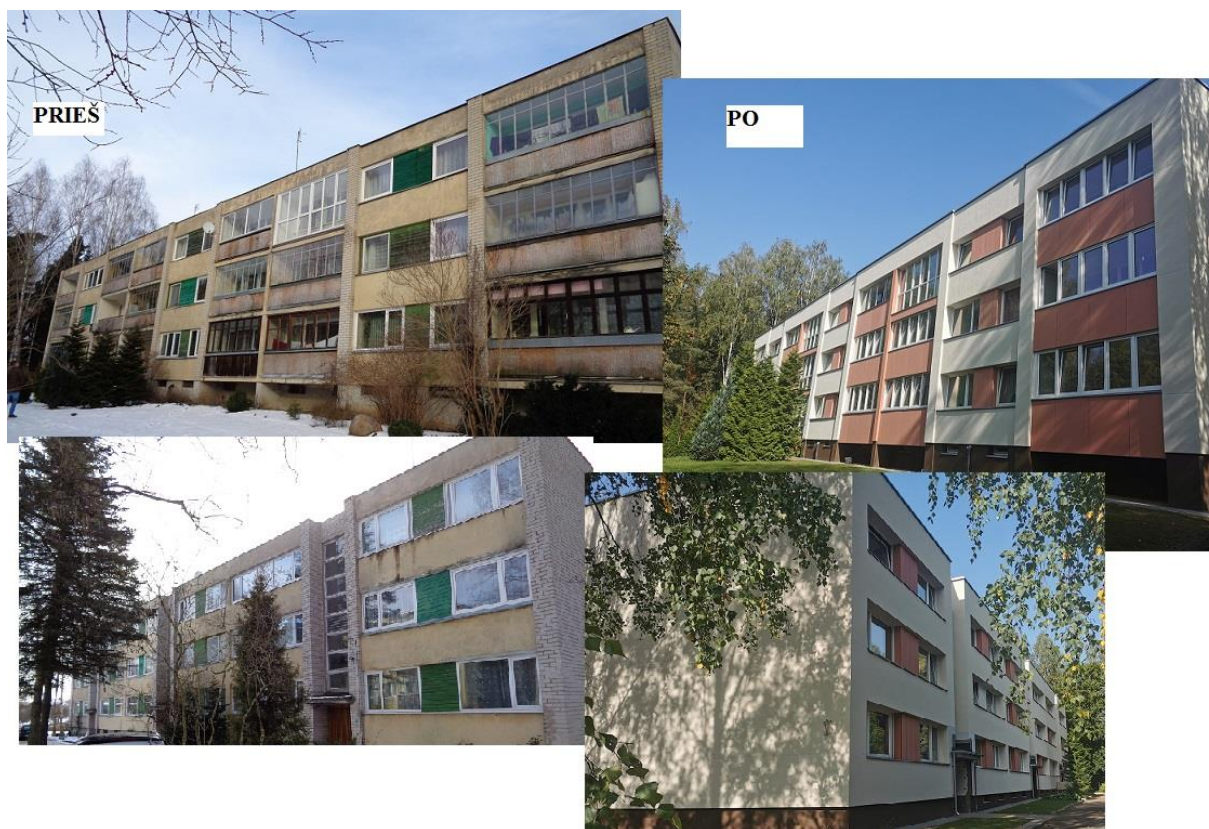
7.2.pav.Parko g. 8, Buivydiškių k., Vilniaus r. atlikti daugiabučio namo atnaujinimo modernizavimo darbai
